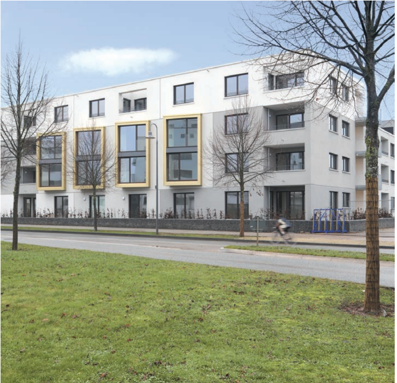
Das vielschichtige Innenleben des Wohnkomplexes kehrt sich mit einer in Oberflächenstruktur und Putzfarben variierenden Fassadengestaltung nach außen.
