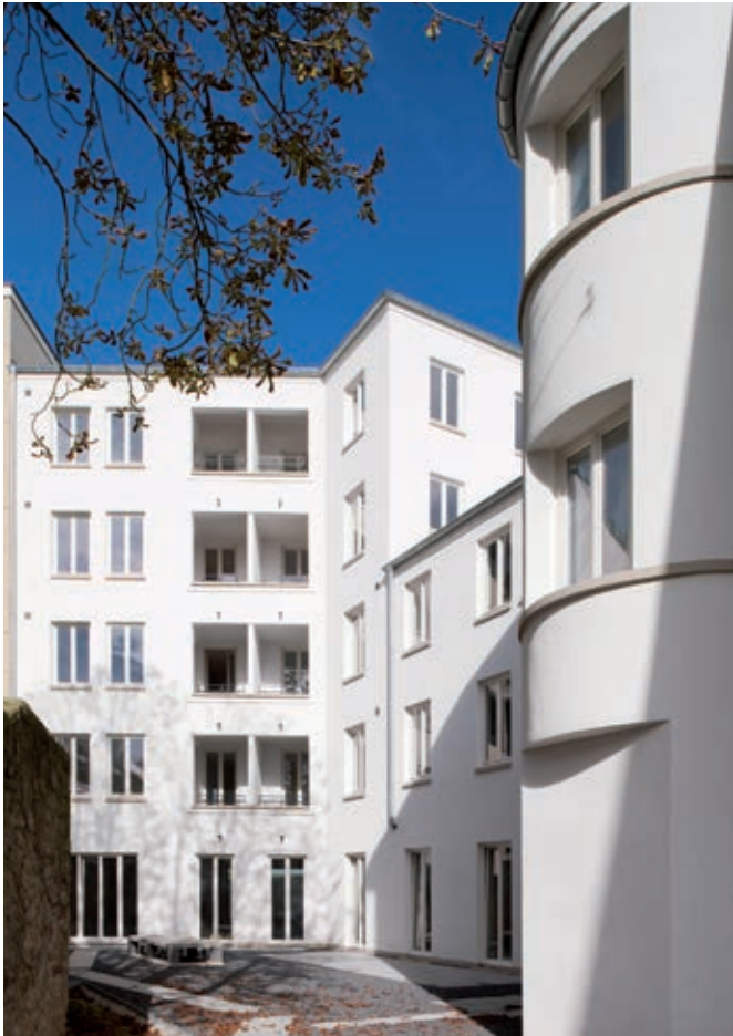
Die Hinterhäuser bilden zusammen mit der Nachbarbebauung einen gemeinsamen Innenhof.
