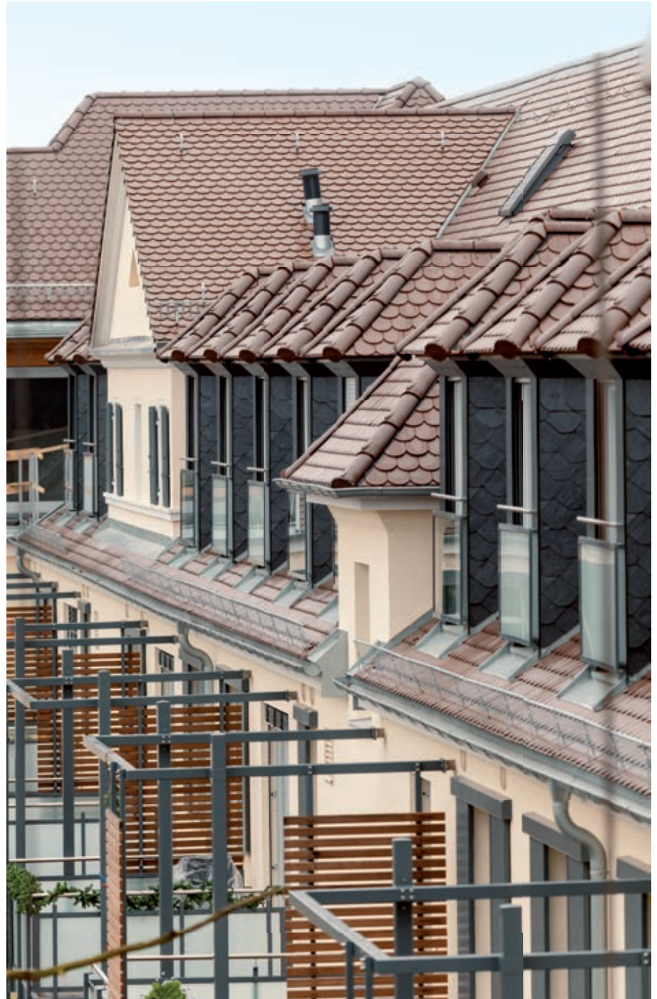
Der behutsame Ausbau der Dachgeschosse mit vergrößerten Gauben, teils als Maisonette angelegt, schafft zusätzlichen Wohnraum.
